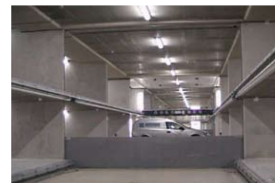
Branddeur in actie tijdens geslaagde proef
