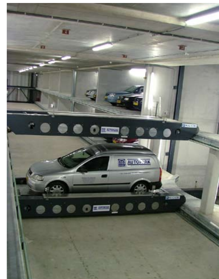
Interieur met platform
