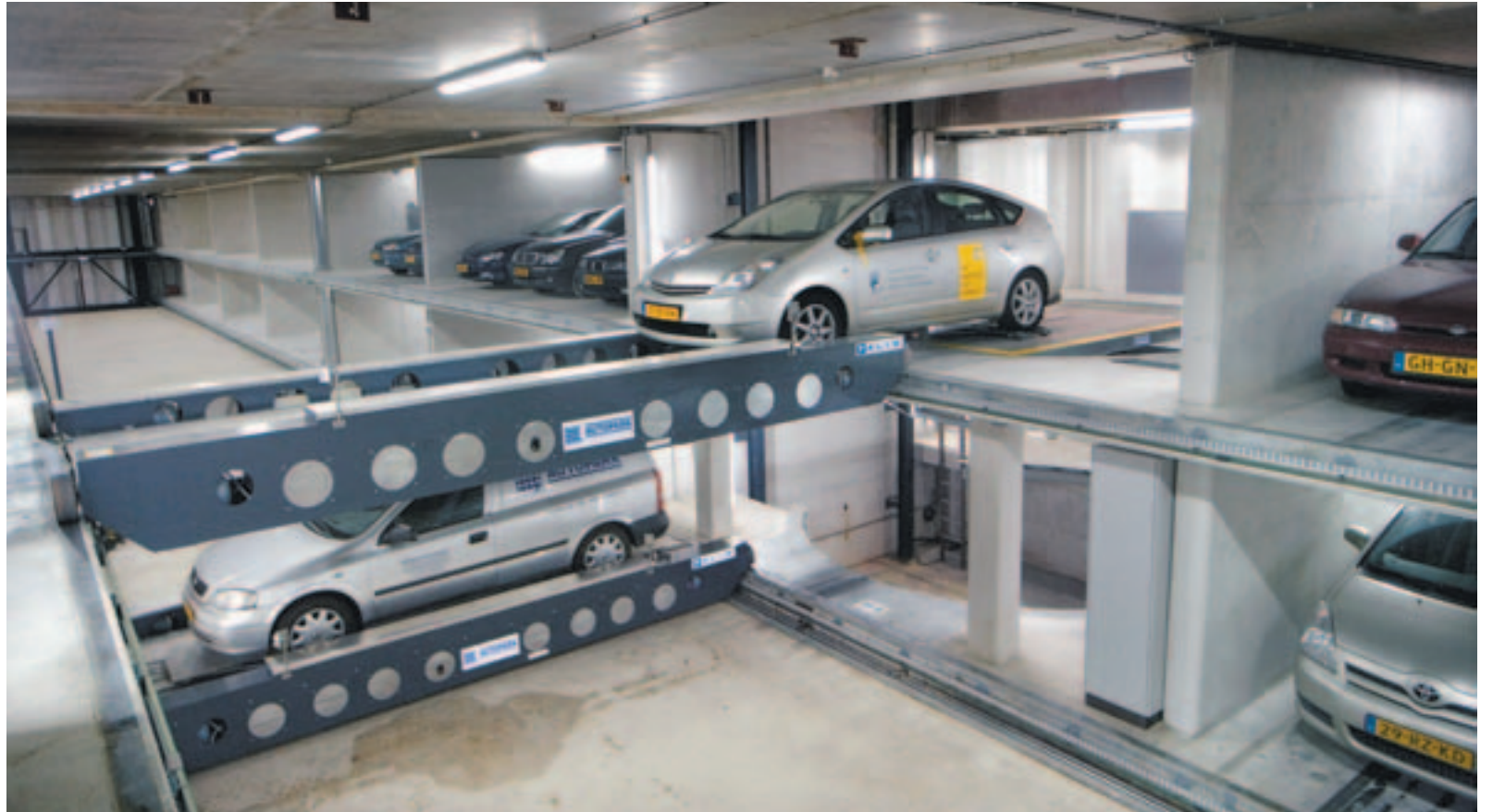
Een lift en een plateau brengen de auto naar een lege parkeerplaats onder de grond.
